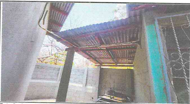
Foto 5: Cerramiento de muro perimetral para cocina
