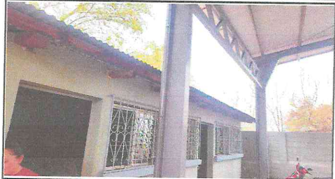
Foto 2: Sustrucción de lámina, por lámina troquelada aluzinc calibre 26
