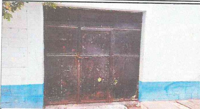
Foto 1: Sustrucción de portones de metal 2.5x2.5
